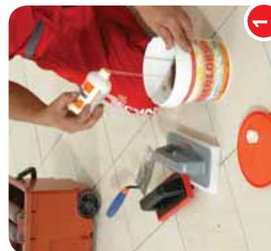
lenter completamente el catalizador (componente B) en la pasta (compo-
